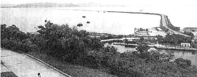
海水と淡水を完全に分離。鉄道、車道二車線、歩道もつけられ、堰堤が8キロも続いている(南浦市)
